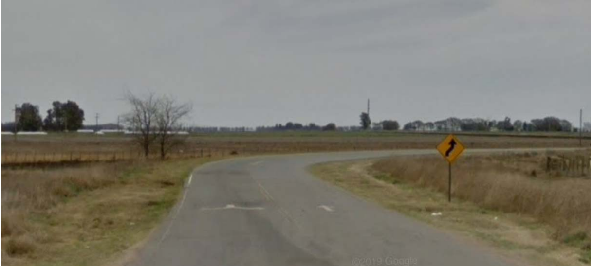
Imagen 5. Deterioro en el Cno. Sec. 050-03. Partido de Gral. Villegas
